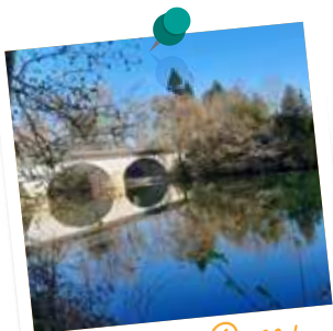
Pont de Roffit
